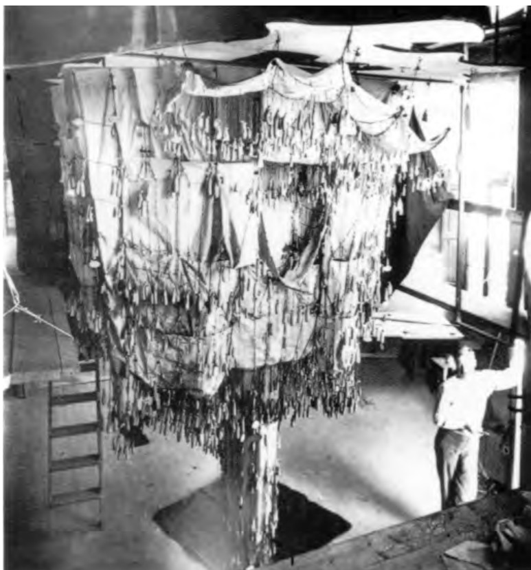
FIGURA 7. Fotografia de la maqueta de fils original. (Font: Càtedra Gaudí.)
